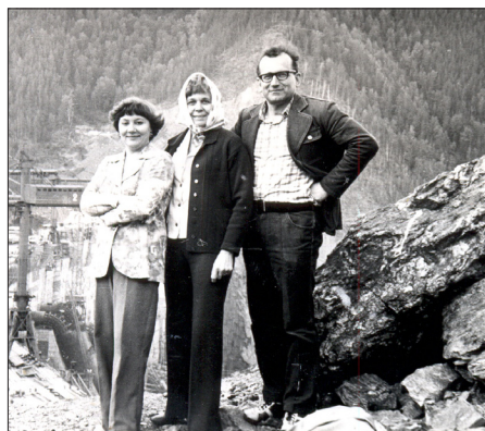
На строительстве Саяно-Шушанской ГЭС
